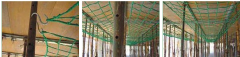
Secuencia de la instalación de una RED DE FORJADO Sistema B. / Installation sequence for a System B FORMWORK NET
