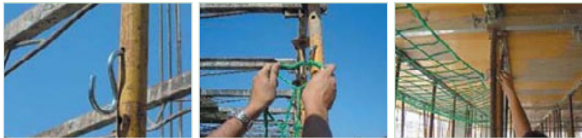
Secuencia de la instalación de una RED DE FORJADO Sistema B. / Installation sequence for a System B FORMWORK NET
